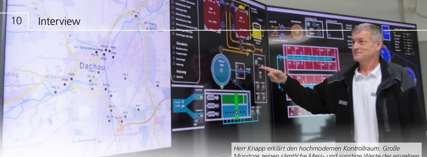
Herr Knapp erklärt den hochmodernen Kontrollraum. Große Monitore zeigen sämtliche Mess- und sonstige Werte der einzelnen Klärbereiche in Echtzeit an. Links: Dachauer Stadtplan, auf dem alle Pumpwerke (PW) und Pumpstationen (PS) eingezeichnet sind. Mitte: Mechanische Klärung und Vorklärbecken. Rechts: Biologische Reinigung in Bakterienbecken. Ganz rechts, z.T. verdeckt: 3 Nachklärbecken
