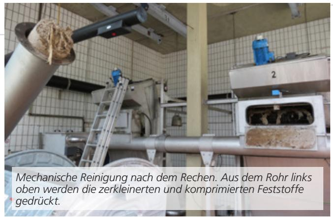
Mechanische Reinigung nach dem Rechen. Aus dem Rohr links oben werden die zerkleinerten und komprimierten Feststoffe gedrückt.
